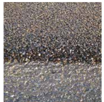
2. Lo strato d'usura in asfalto open-graded
