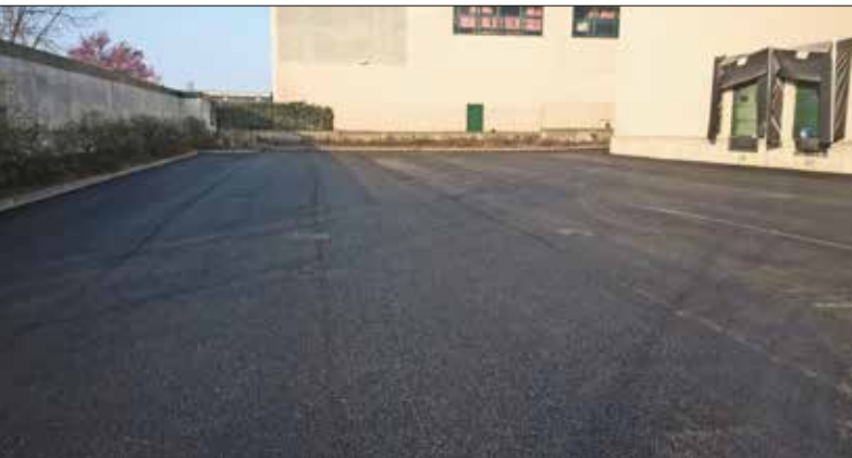
3. Vista complessiva dell'asfalto nuovo applicato
