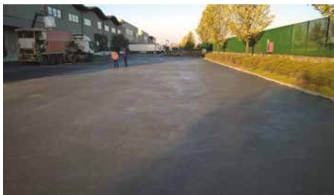
6. Vista della pavimentazione prima del rifacimento
